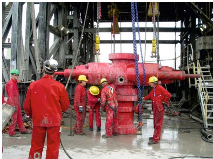
**Abb. 4.1.3** Montage eines Elementes des Blowout Preventers unter der Arbeitsbühne
